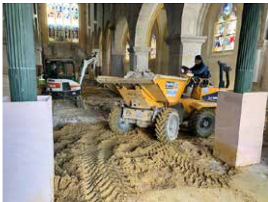
Le nouveau sol est préparé.
