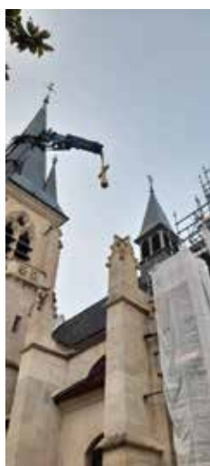
Installation de la croix.
